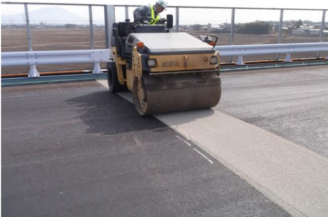
G・Asシート敷設後転圧状況 幅100cm
