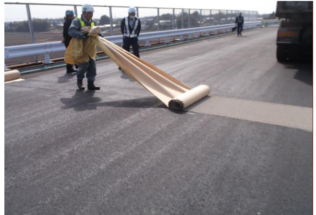
G・Asシート敷設状況 幅100cm
