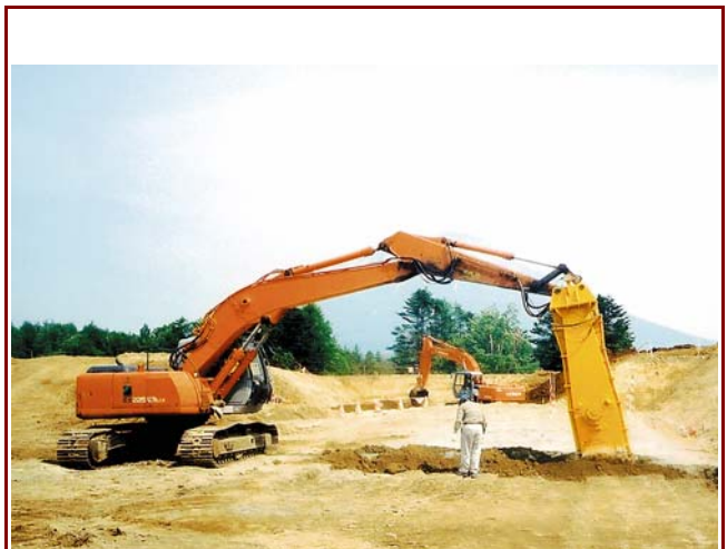
施工状況:粉体散布方式
