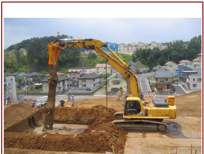
施工状況:深度10m施工(アタッチメント付)
