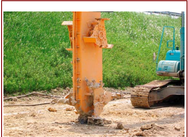
専用攪拌装置:ロータリーブレンダー方式
