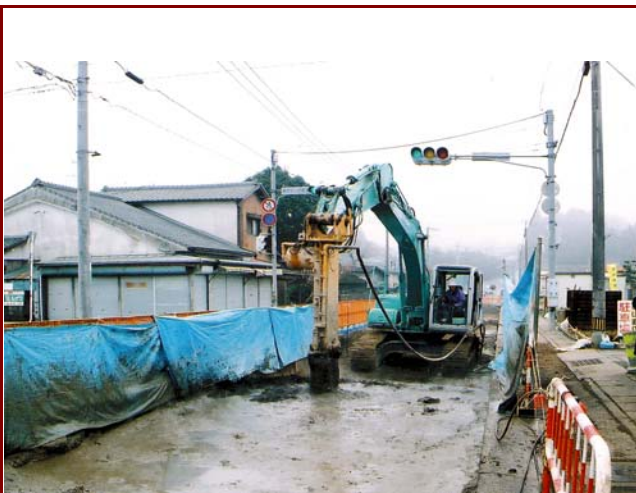
施工状況:スラリー混合方式
