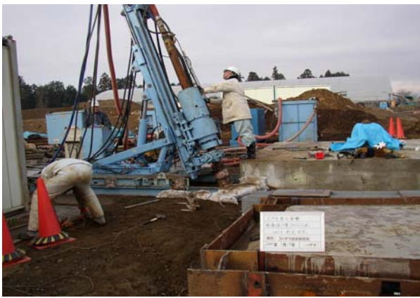
補強体造成状況.jpg
