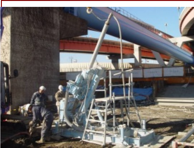
綾瀬川水管橋耐震補強工事.jpg
