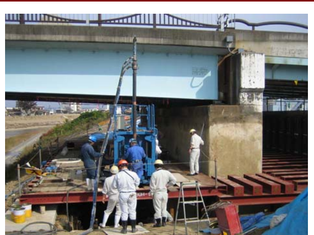
昭栄大橋左岸橋脚補強工事.jpg
