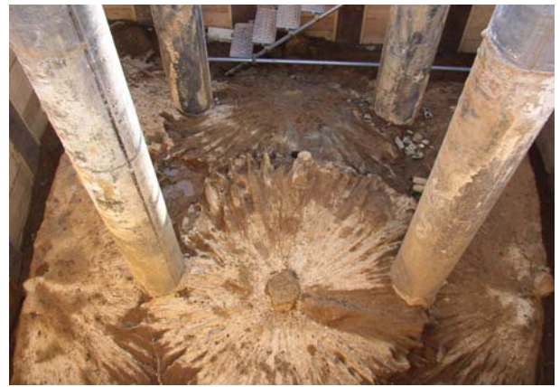
補強体出来型状況.JPG
