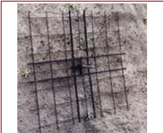
補強部材設置状況
