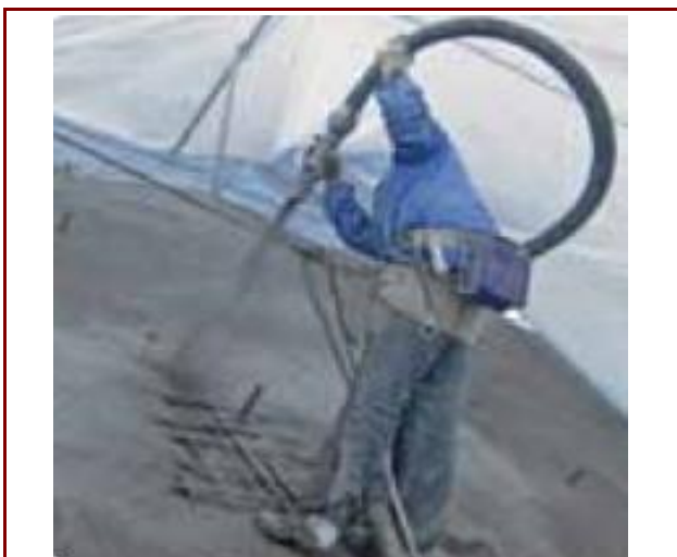
繊維補強モルタル吹付状況
