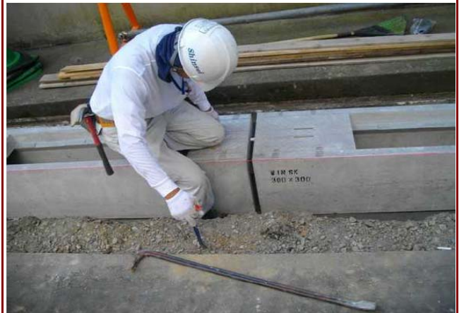
製品施工写真
