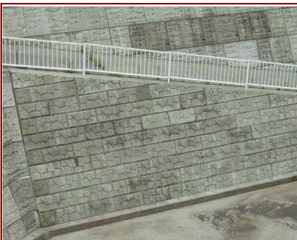
平成19年度 富士市神戸土地区画整理事業 調整池築造工事
