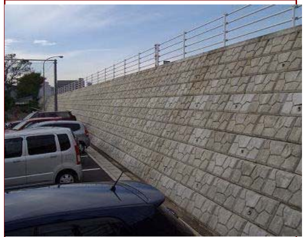
平成17年度狩野川御幸町地区護岸修繕工事
