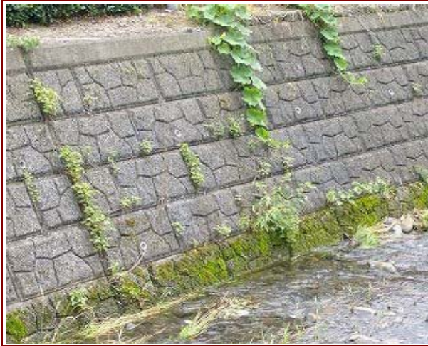
平成14年度内牧川河川災害復旧工事
