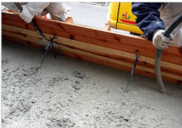
型枠に沿ってピカコンを差し込む
