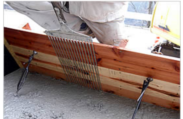
差し込んだピカコンを引き上げる
