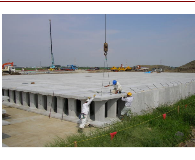
ハニカムボックス据付状況
