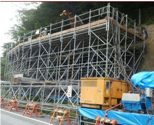
道路改良工事(アンカー工)
