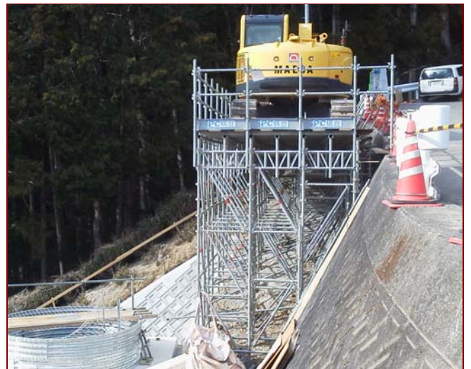
平ノ尾(集水井工)
