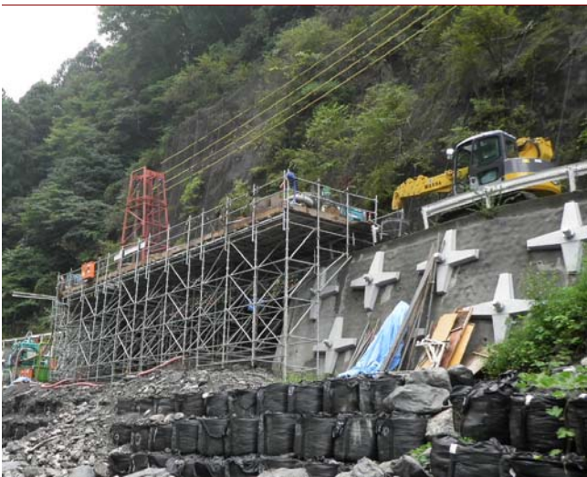
道路改良工事(大口径)
