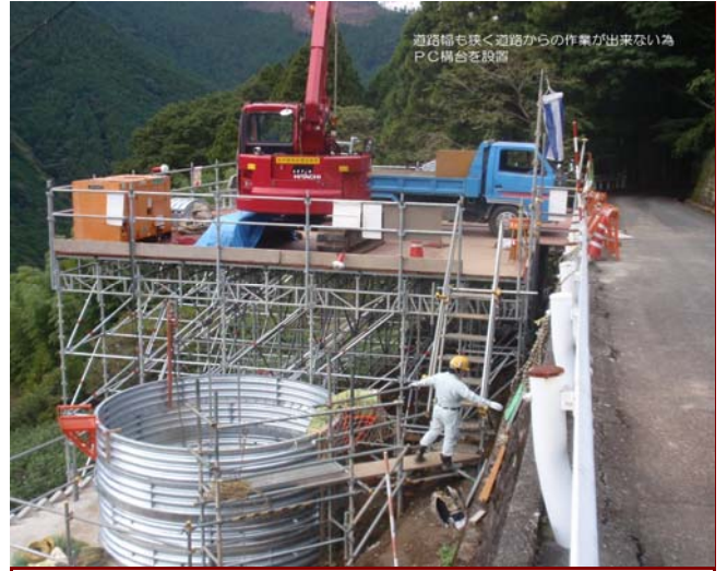
天竜大滝(集水井工)
