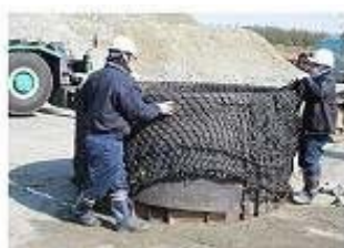
①袋材設置 (袋の底を地面につけて設置)
