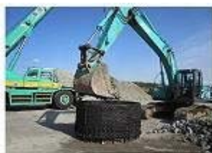
②中詰め材投入
