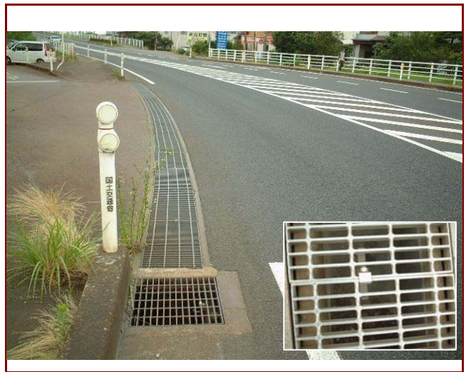
設置例(道路側溝・N I 型)
