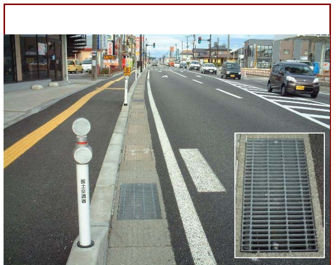
設置例(道路側溝・N II 型)
