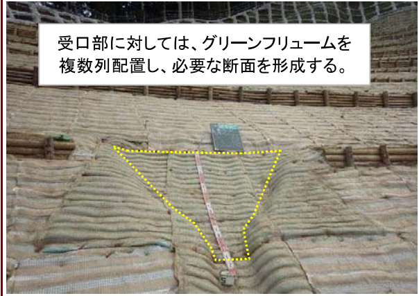
受口部の施工事例
