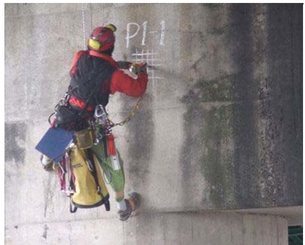
橋脚・シュミットハンマー測定状況
