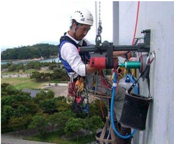
コア抜き状況
