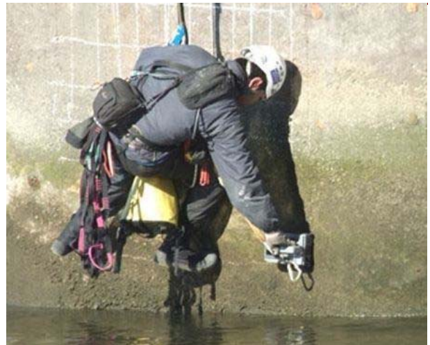
電磁波レーダー法による鉄筋探査状況
