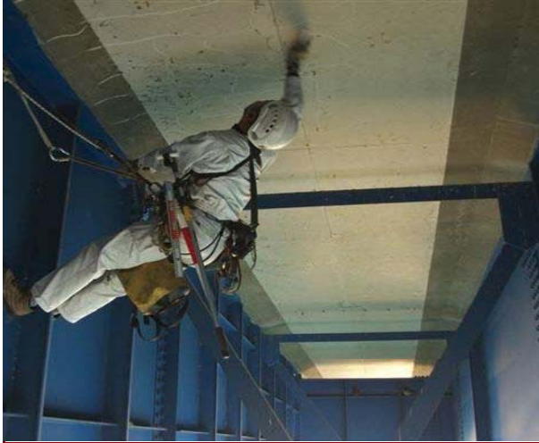
床版調査状況
