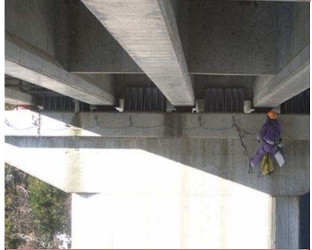
支承調査状況(横移動)
