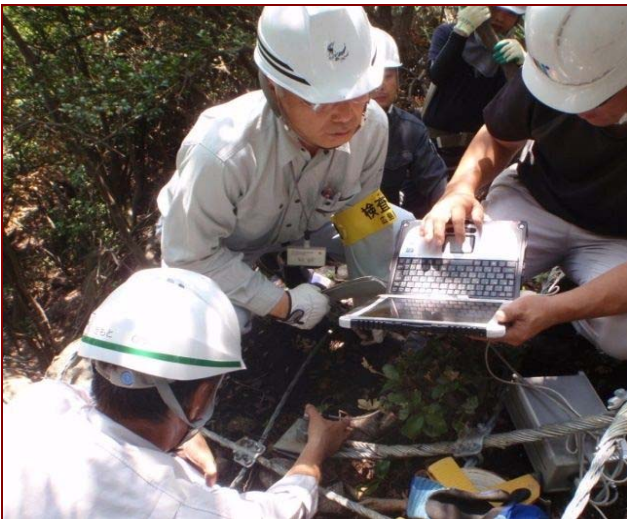
検査時での出来形確認
