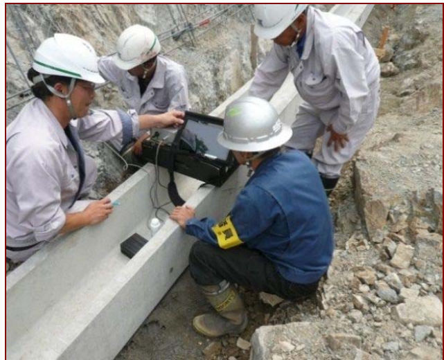
段階検査での出来形確認
