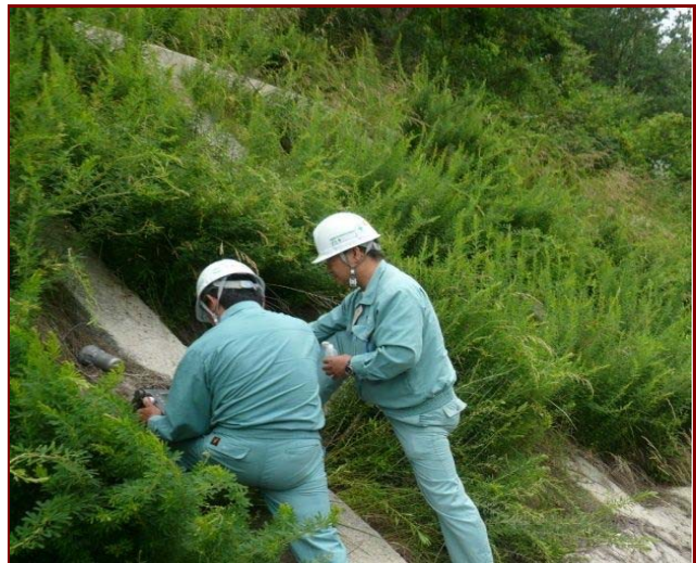
供用中铁筋挿入工の出来形確認
