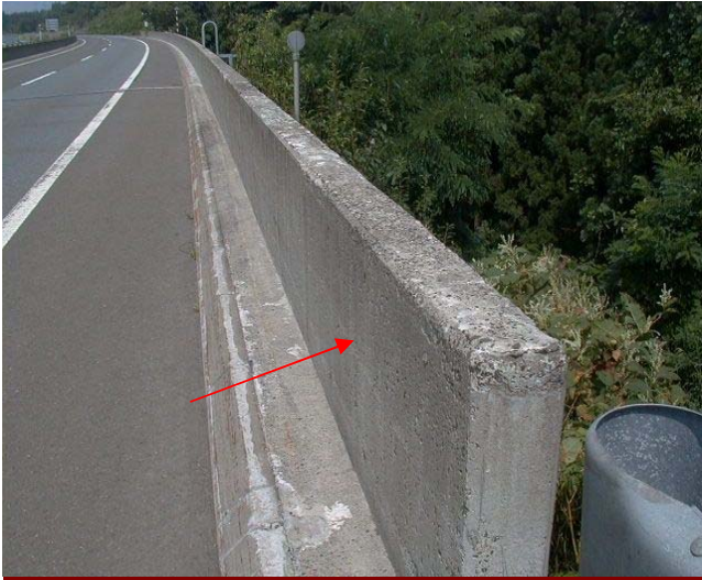
道路補修後施工
