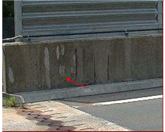
道路劣化部分の補修
