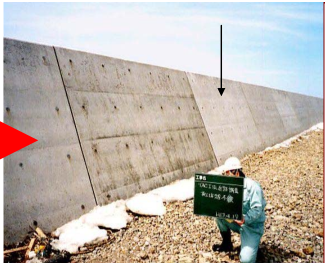
防波堤施工後
