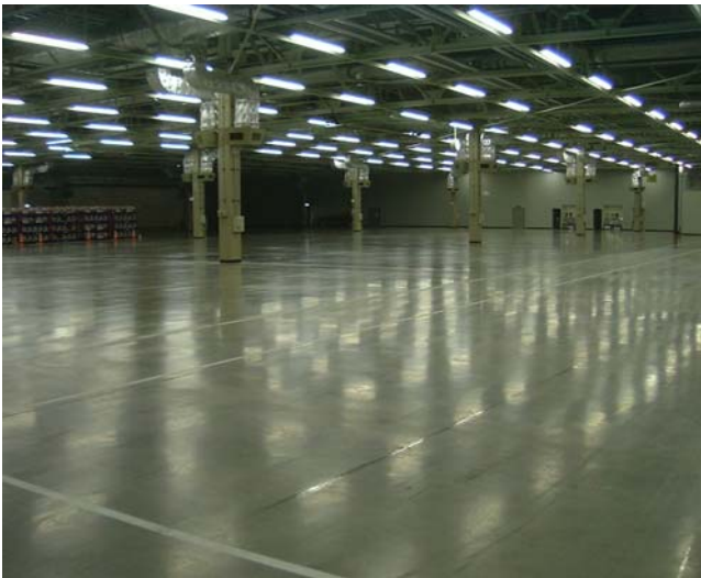
工場内床面施工後
