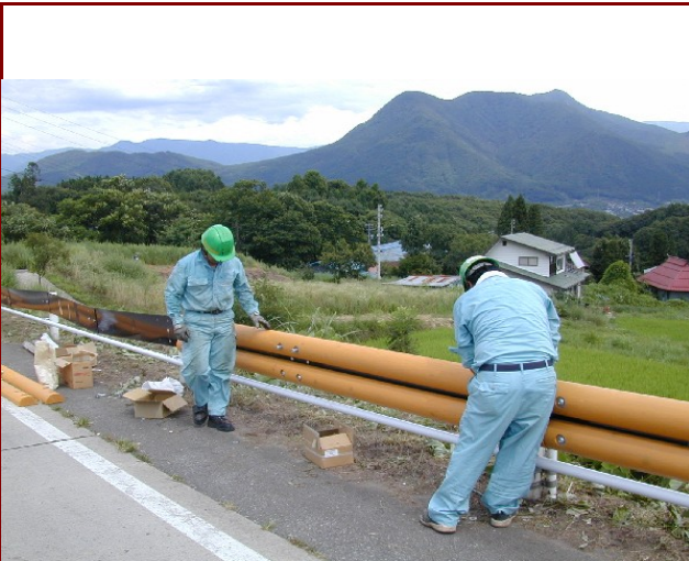
アンダーバー、鋼ビーム、木ビーム取付
