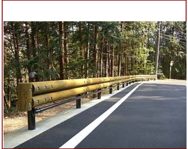
伊豆市月ヶ瀬 (天城湯ヶ島地区集落道合併2工事)
