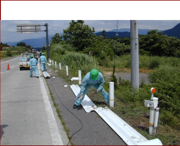
既設鋼ビーム取り外し(既存支柱使用)
