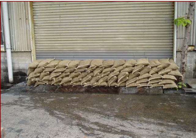
施工例 (75袋使用)
