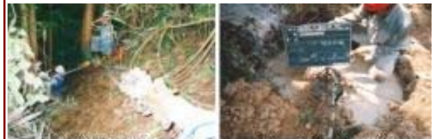
生立木使用によるアンカー引張り試験
