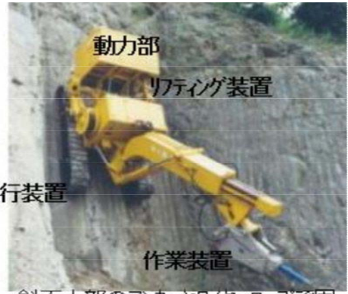
斜面上部のアンカーとワイヤーロープで固定され作業中の高所岩盤掘削機
