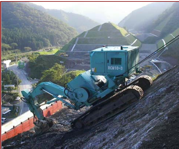
高所岩盤掘削機
