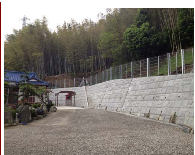
急傾斜地崩壊対策工事
