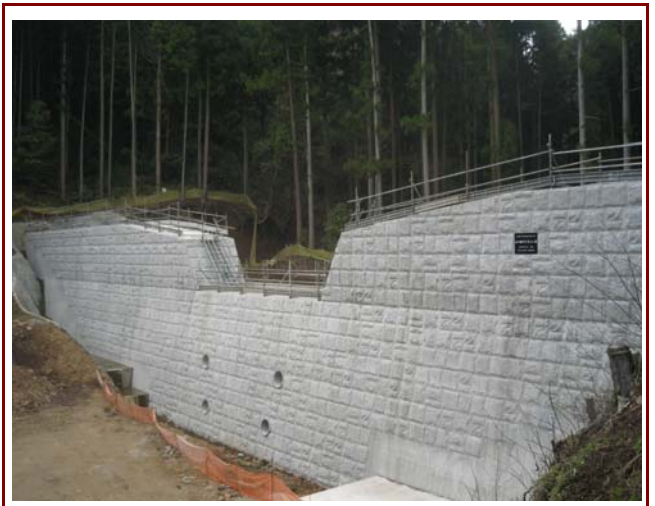
砂防堰堤天端安全対策の例
