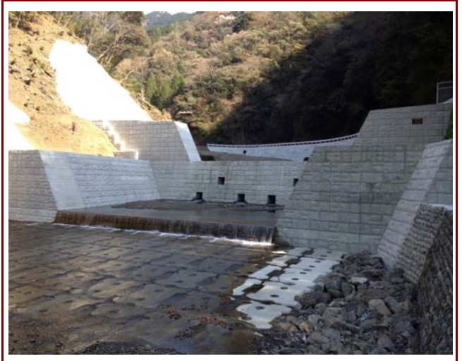
八重沢川砂防堰堤工事(静岡河川国道事務所)
