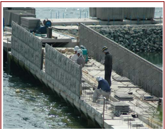
松崎港整備事業岸壁工事(下田土木事務所)
