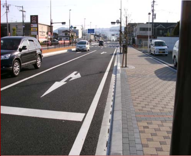
静岡市役所: 丸子池田線街路築造工事
