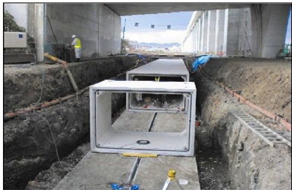
マルチ搬送機工法・マルチレベル工法併用による据付
