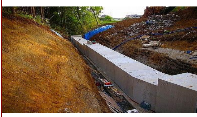
マルチ搬送機工法・マルチレベル工法併用による据付
