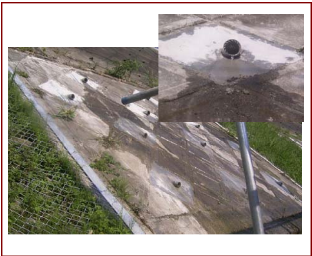
既設擁壁の施工事例
