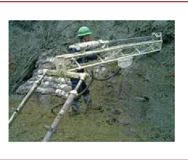
打込み施工状況
