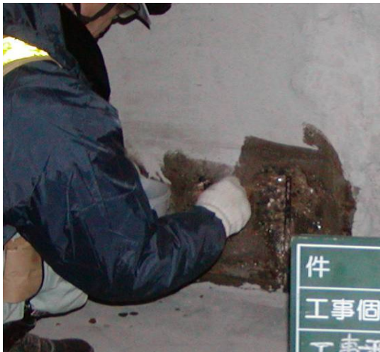
マクサムサンドイッチ(断面修復)工法マクサム塗布写真
