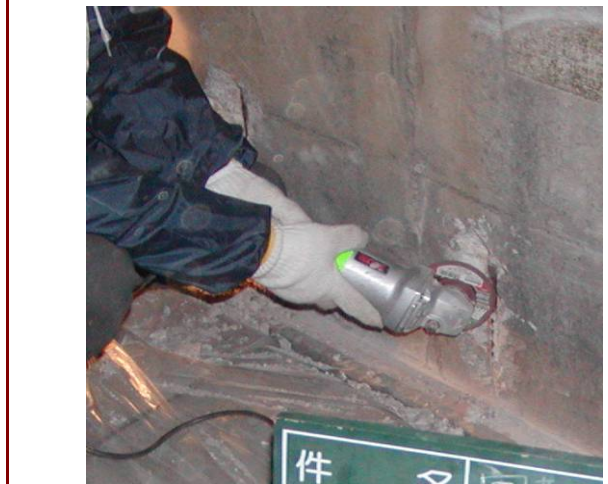
マクサムサンドイッチ(断面修復)工法鉄筋ケル写真
