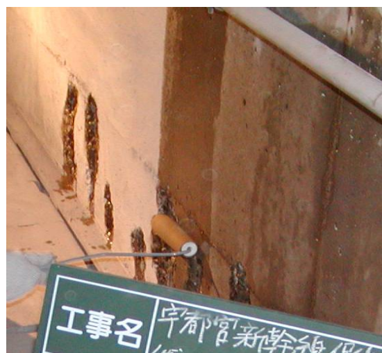
マクサムサンドイッチ(断面修復)工法マクサム塗布(全体)写真
