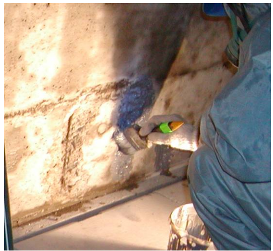
マクサムサンドイッチ(断面修復)工法防錆処理写真
