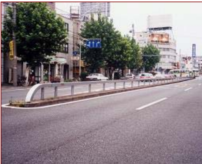
国道2号線ボックスビーム
