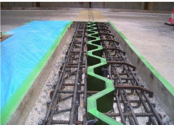
S・L・LLタイプ施工状況写真
