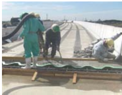
6. コンクリート打設
