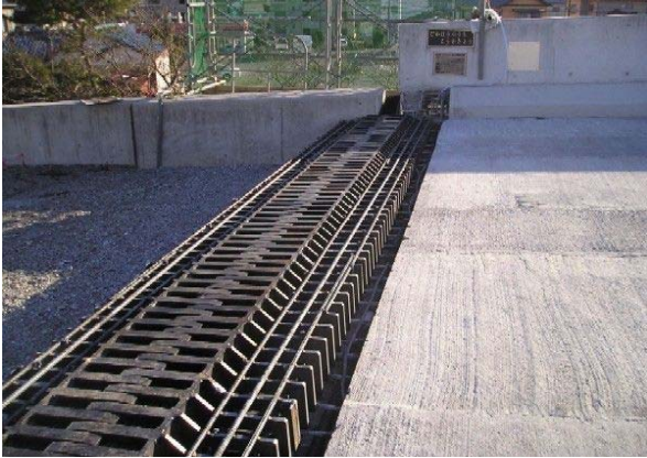
3Lタイプ施工状況写真
