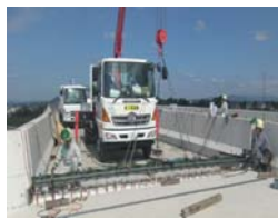
1. 伸縮装置設置
