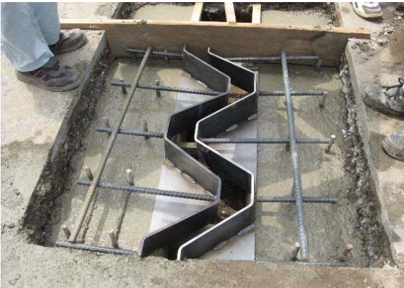
NRCタイプ施工状況写真
