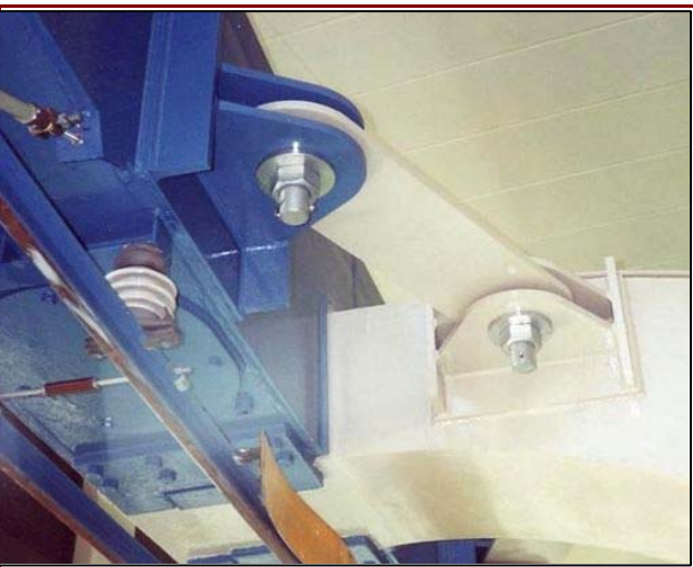
モルレルでの設置例 (変位制限構造)
