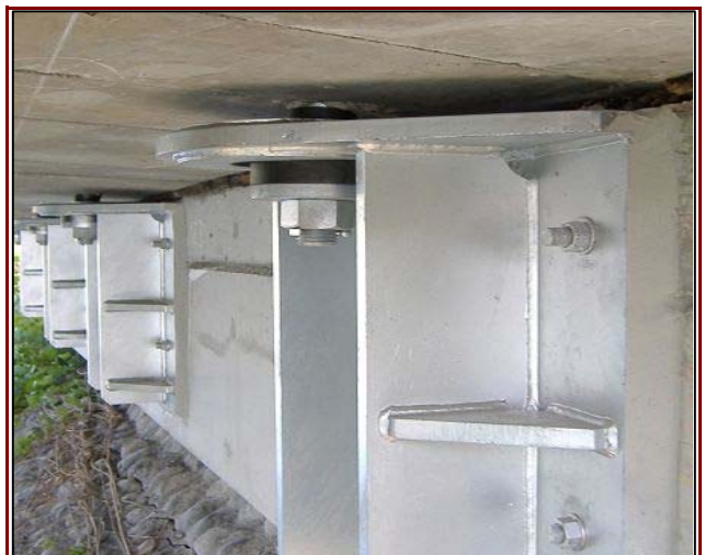
PC上部工設置例 (橋軸・橋軸直角方向変位制限構造)
