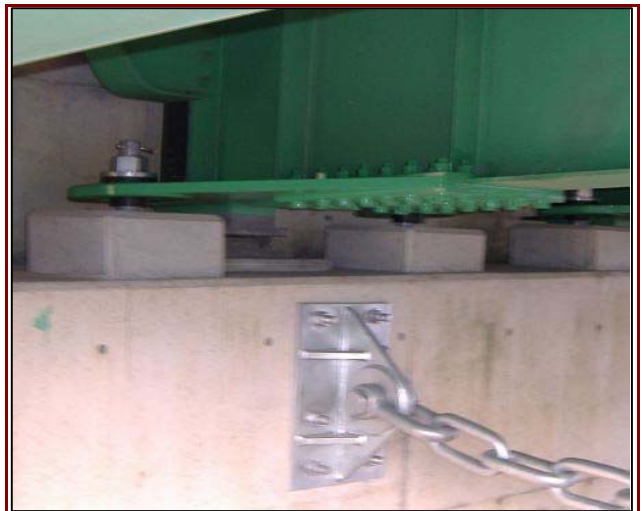
メタル桁設置例 (橋軸・橋軸直角方向変位制限構造)
