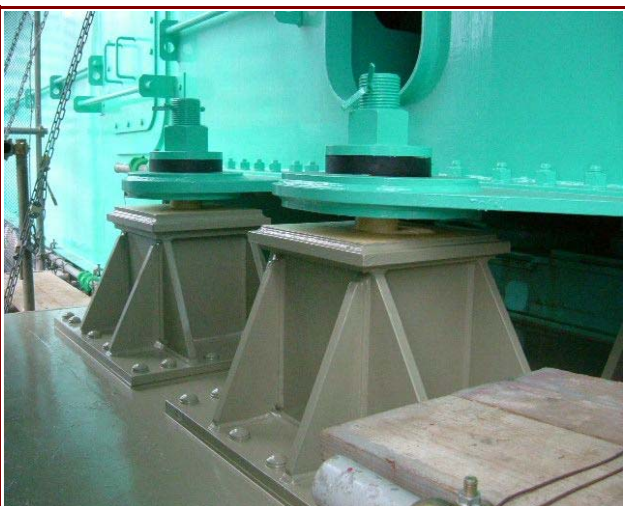
鋼製箱桁+鋼製橋脚設置例 (橋軸・橋軸直角方向変位制限構造)
