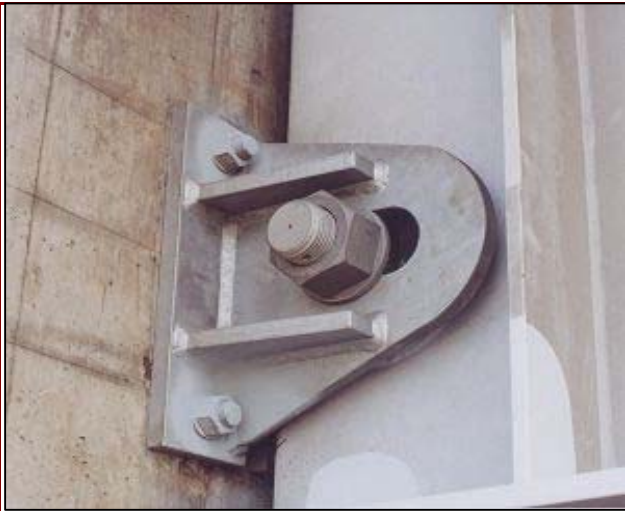
鋼上部工設置例(橋軸方向変位制限構造)
