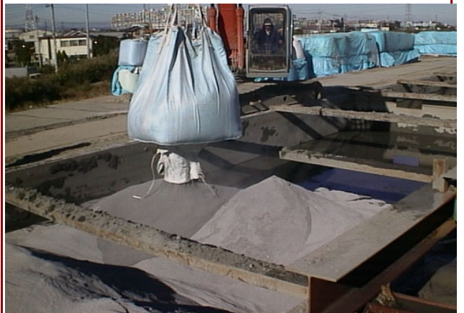
写真-6 河川浚渫土処理施工状況
