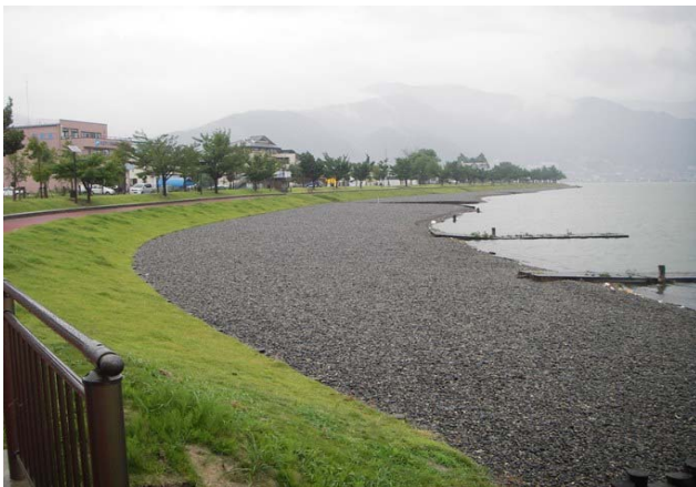
写真-5 処理土諏訪湖湖岸盛土利用
