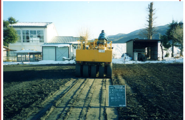
写真-4 校庭盛土施工状況
