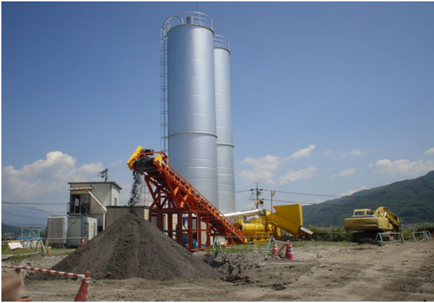
写真-1 FTマッドキラー工法設備全景
