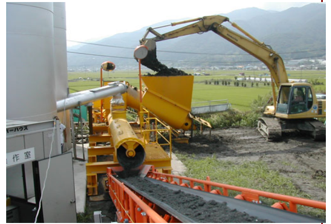
写真-2 専用ミキサー状況
