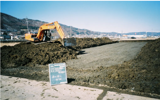
写真-3 田底土盛土施工状況
