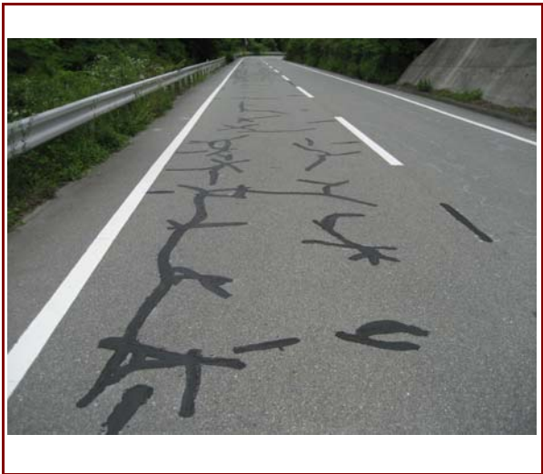
クラックカットシール 施工完成写真
