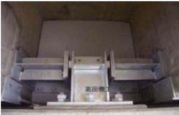
ポストテンT桁の設置例
