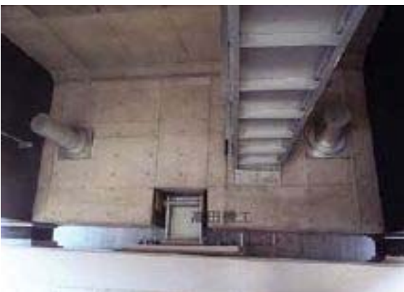
鋼2主I桁の設置例
