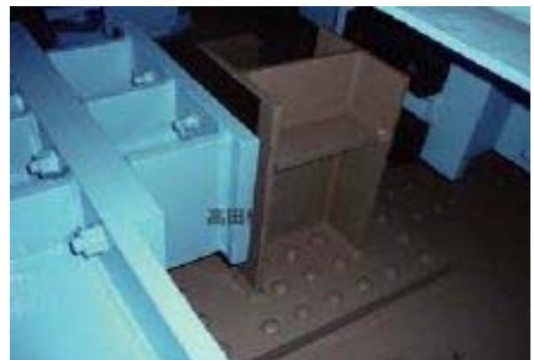
鋼I桁、鋼製橋脚の設置例
