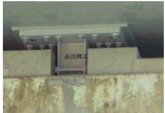
PC箱桁の設置例
