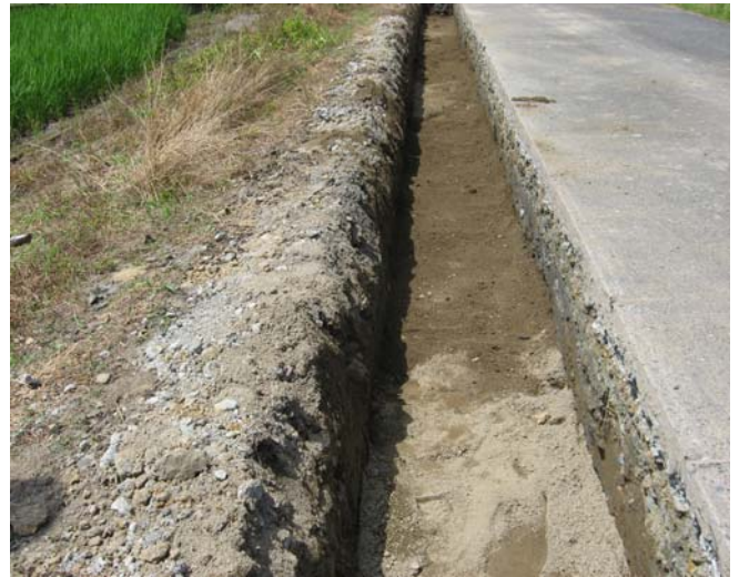
土質改良土0-5路体材、施工完了
