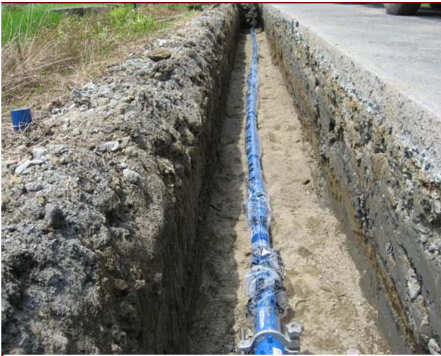
土質改良土0-5路体材、施工状況
