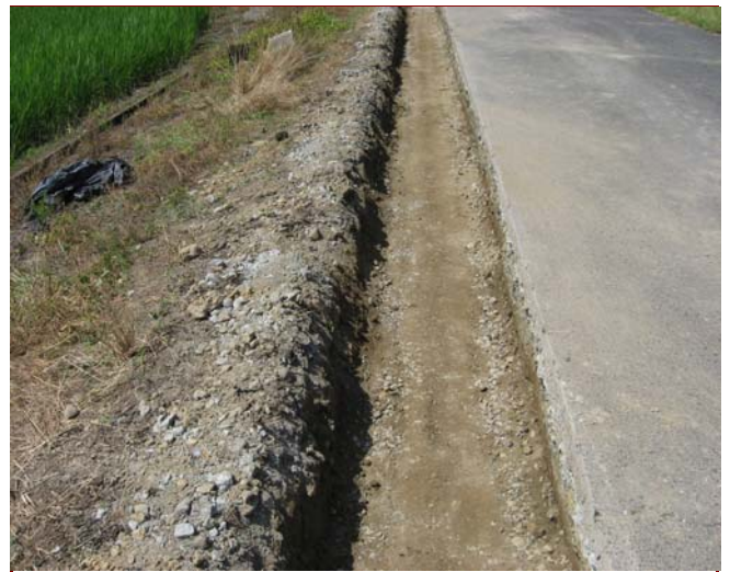
土質改良土0-40路床材・路体材、施工完了
