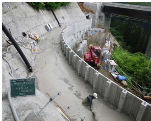
気泡混合軽量材打設状況
