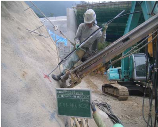
せん断ボルト設置状況
