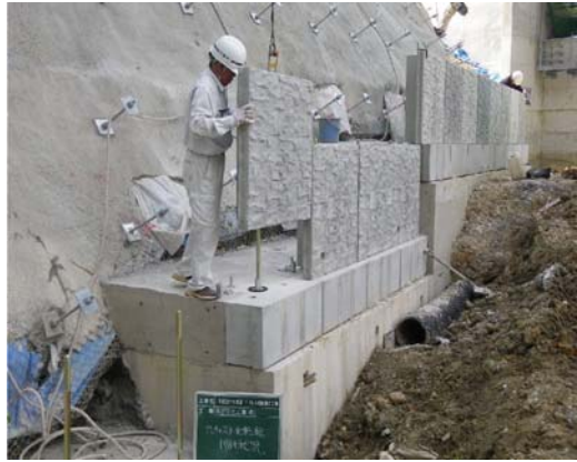
N-SPCパネル設置状況
