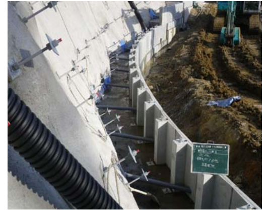
配水管設置状況
