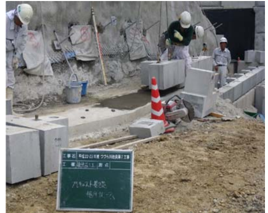
基礎ブロック設置状況
