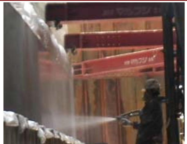
施工状況: 中塗り(SQS材吹付け)
