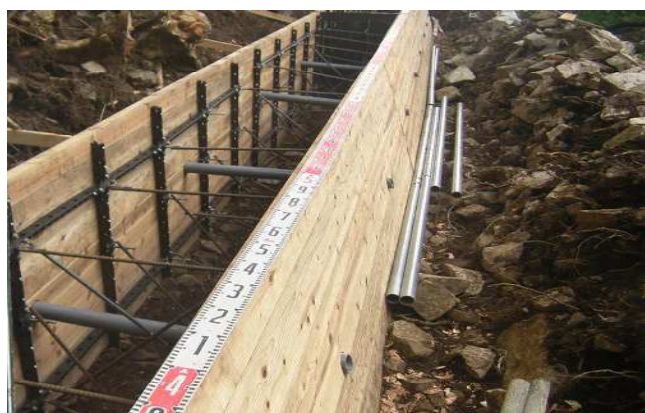
擁壁工施工状況
