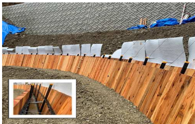
等厚コンクリート擁壁施工状況
