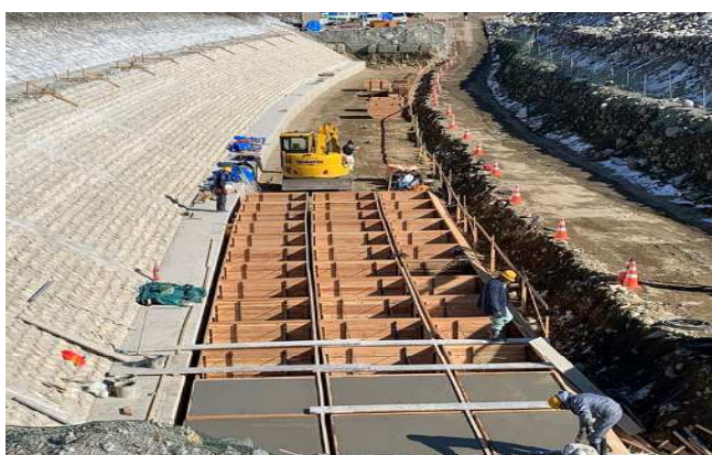
大田切川施工状況
