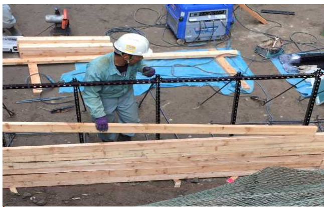
治山型枠内施工状況
