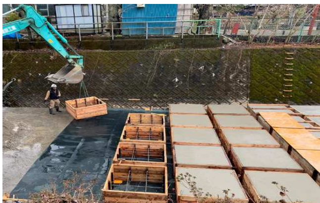
大場川施工状況
