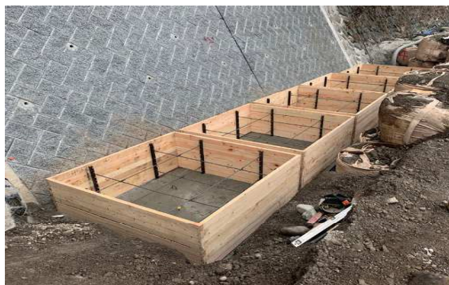
桃沢川施工状況
