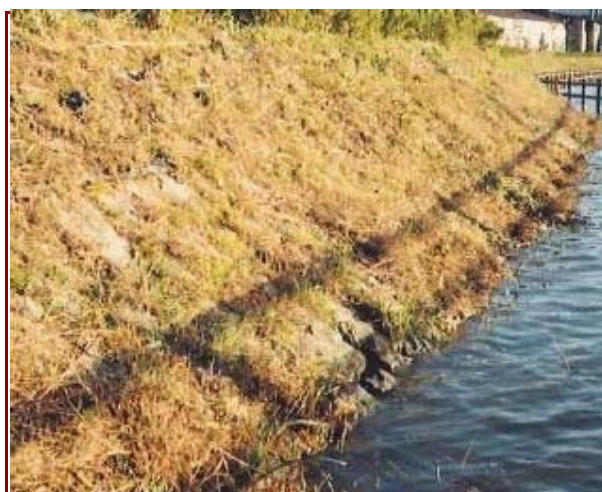
八幡池整備工事
