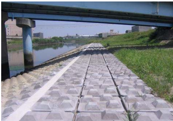
五条川改修工事
