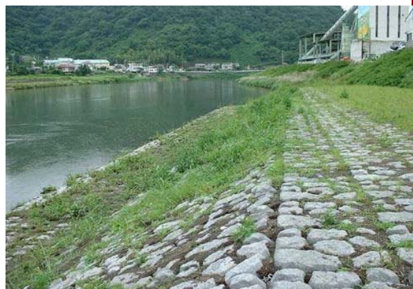
狩野川護岸工事
