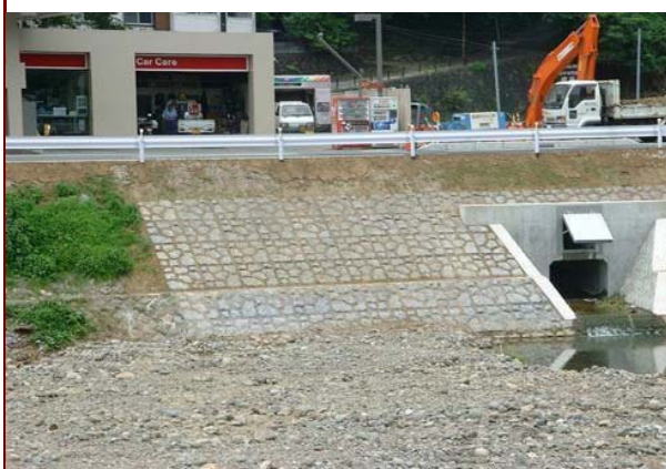
河津川改修工事
