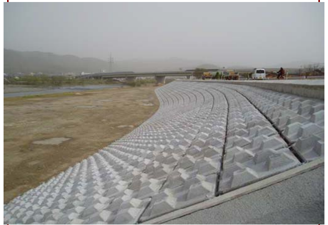
上津谷地区護岸工事
