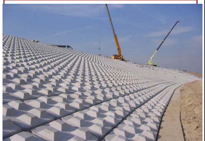
庄内川護岸工事
