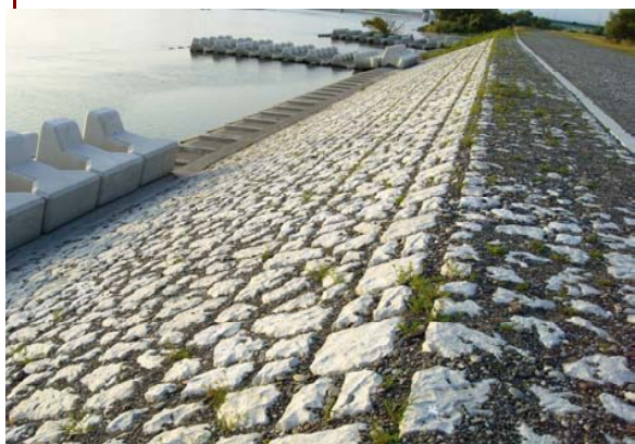
天竜川勾坂護岸工事
