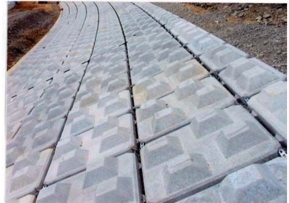
佐保川改修工事
