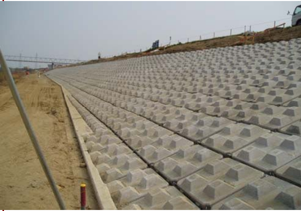
淀川八幡地区護岸工事
