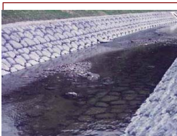
佐東川改修工事
