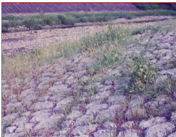
原野谷川改修工事
