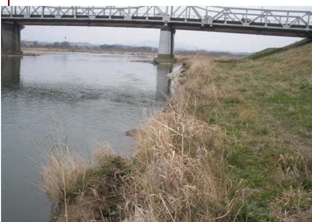
木津川改修工事
