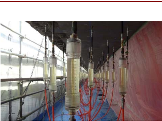
RC床版の補修適用事例
