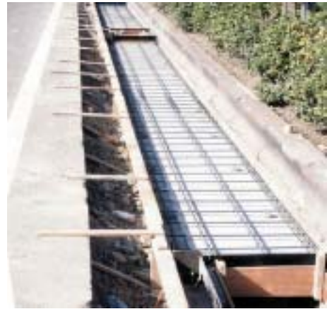
KCフォーム設置、鉄筋加工組立
