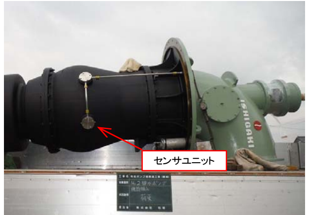
φ 1200ポンプ搬入状況
