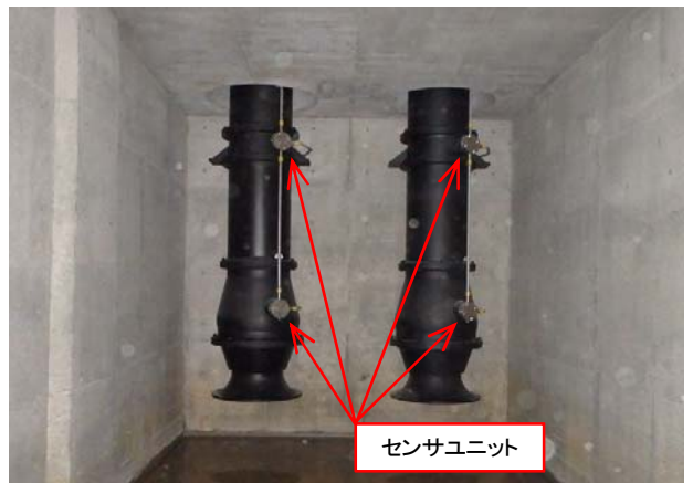
据付状況(吸水槽内)
