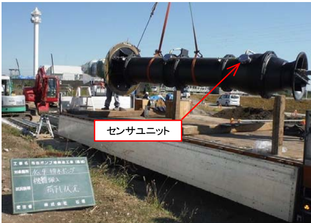
φ 600ポンプ搬入状況
