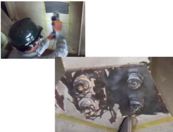
左が従来ディスクサンダー、右が新技術プレストブラスター プレストブラスター 桁とボルト部の施工状況
