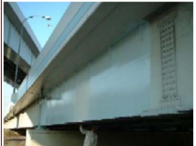
首都高速道路湾岸線
