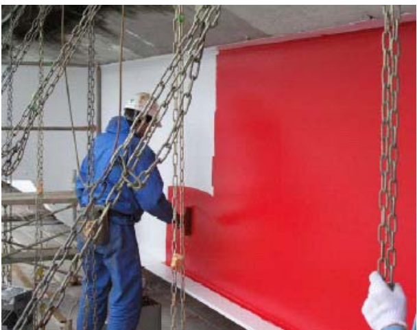
ユニテクト30SFの塗装状況
