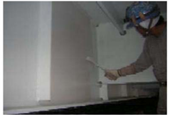
ローラー塗装中の写真
