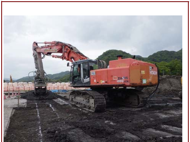
角度変換機能付攪拌機パワーブレンダー施工
