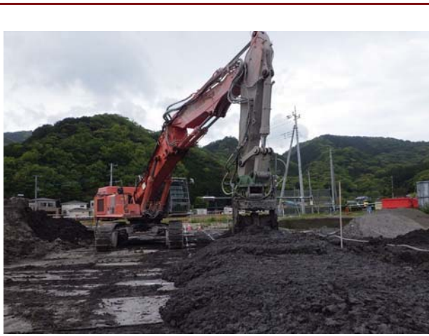
角度変換機能付攪拌機パワーブレンダー施工
