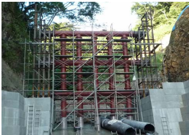
補強材・本体の組立状況
