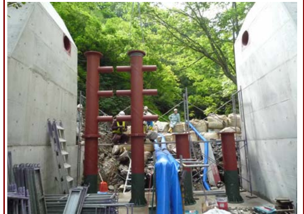
本体施工状況
