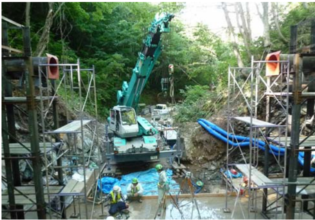
鞘管設置状況
