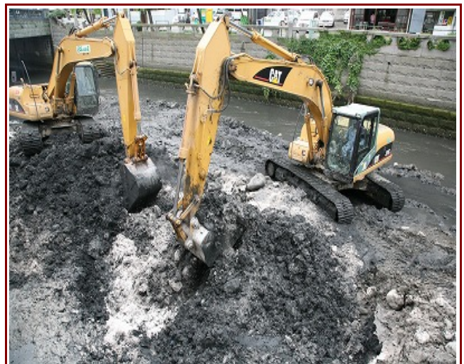
長崎県 中島川広域基幹河川改修工事 (河川敷内の施行)
