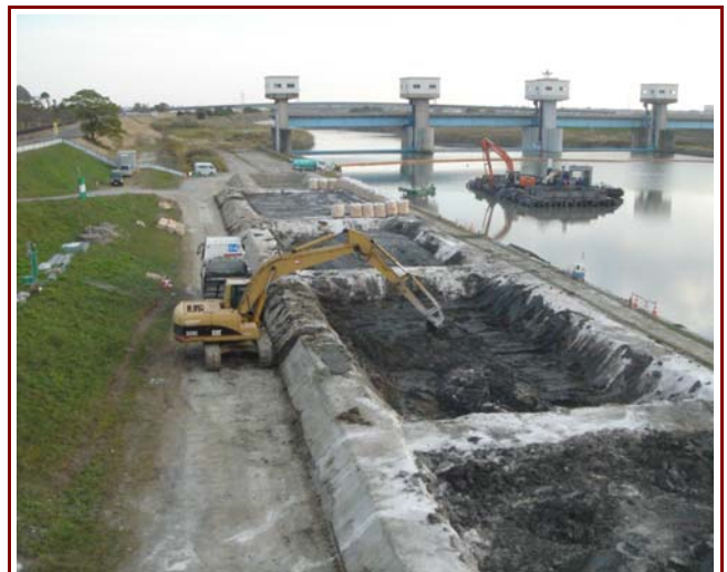
佐賀県 嘉瀬川十五地区河道掘削工事
