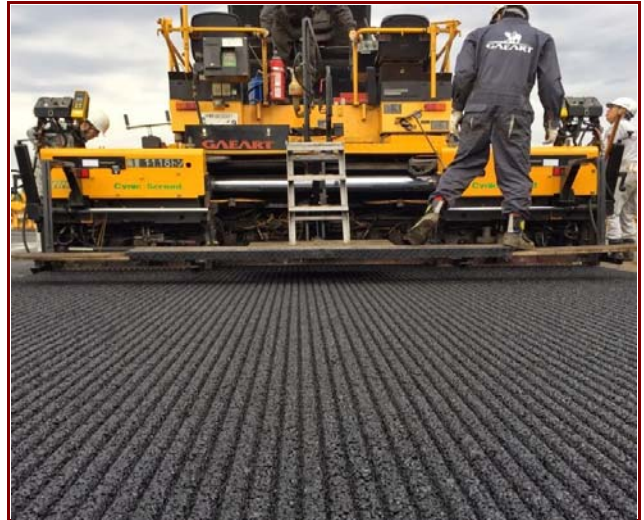
敷き均し状況
