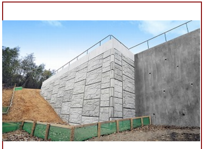
御船造成工事
