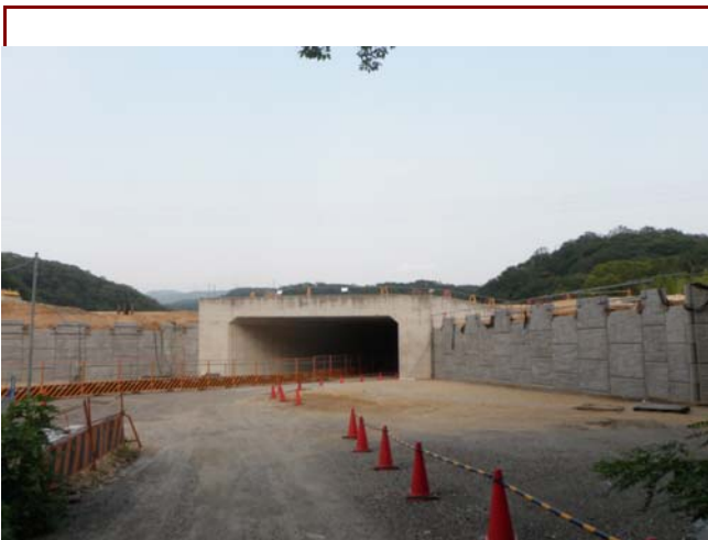
道路改良事業一般国道248号道路築造工事
