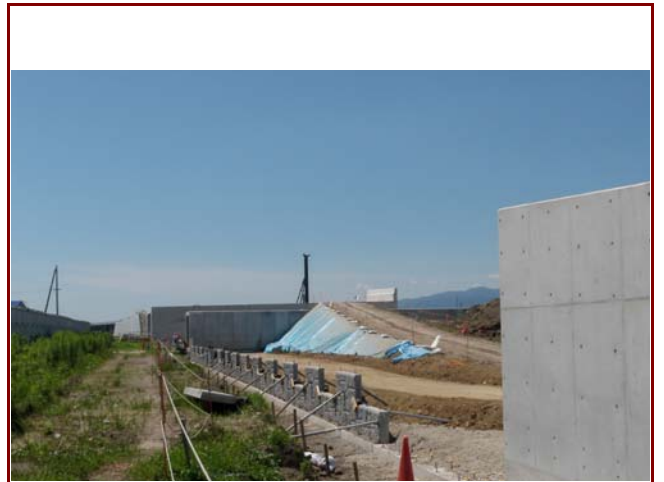
平成21年度23号木造北道路建設工事
