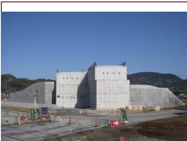
平成20年度1号藤枝岡部高田道路建設工事
