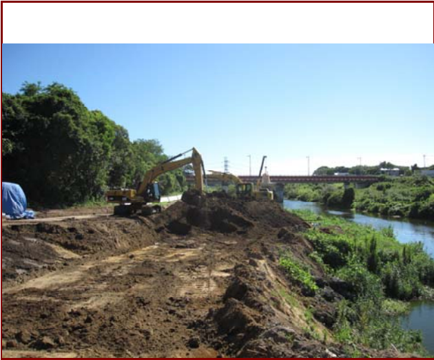
河川浚渫工事
