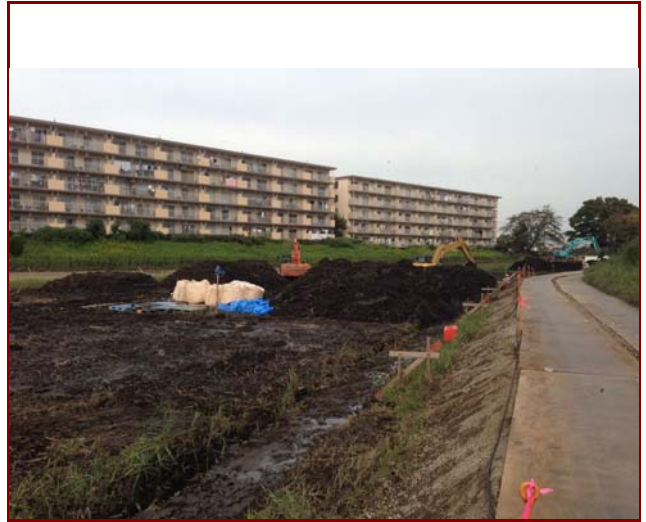
調整池浚渫工事
