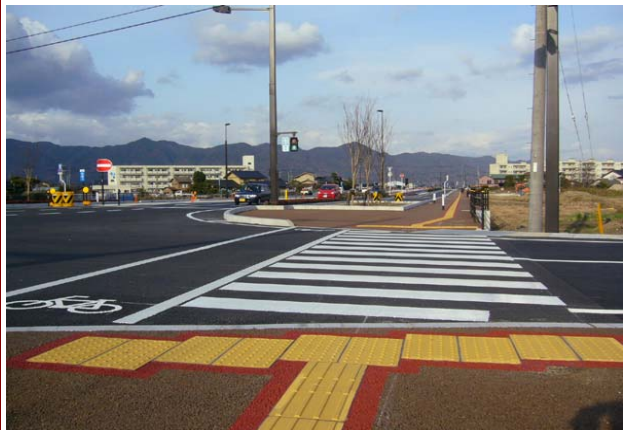
MMA点字タイル施工例
