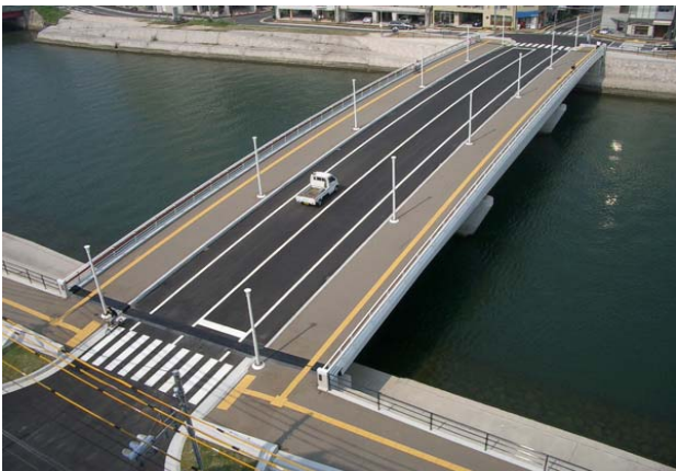
MMA点字タイル施工例
