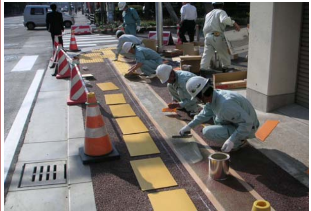
MMA点字タイル施工状況
