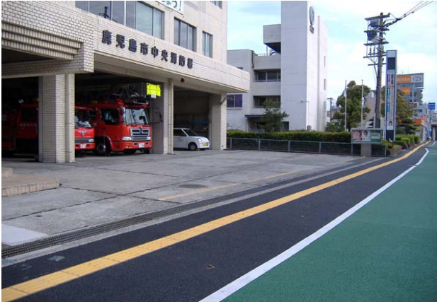
MMA点字タイル施工例(緊急車両出入口)
