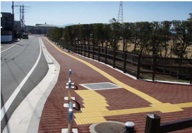
MMA点字タイル施工例
