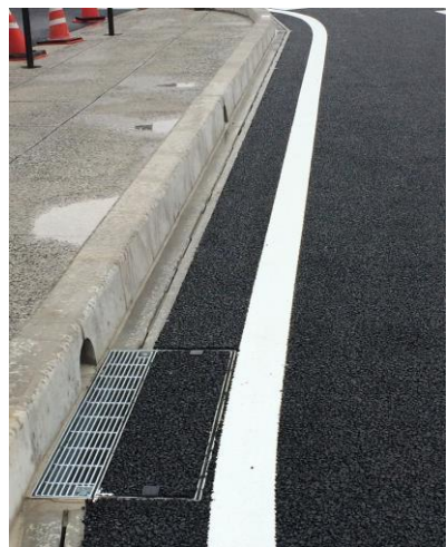
製品施工完了2
