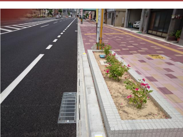
製品施工完了1
