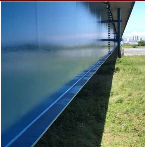
メタモルシート施工例(1)
