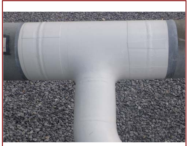
メタモルシート施工例(2)
