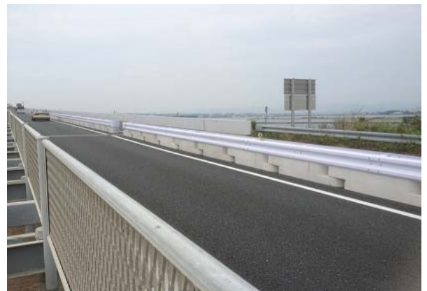
浜名大橋主桁補強工事
