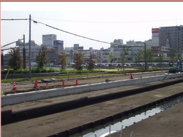
清水駅東口8-3道路工事实績写真
