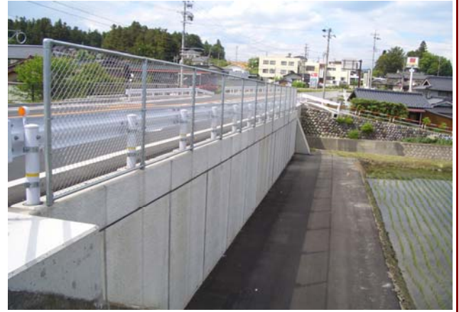
H16、153号大芝道路補修工事实績写真
