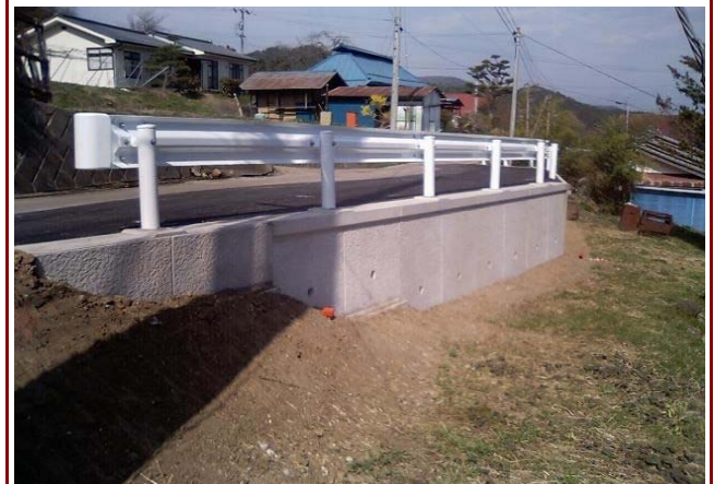
青木村田沢道路改良工事实績写真
