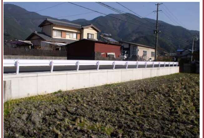
油山橋日向山線道路改良工事实績写真
