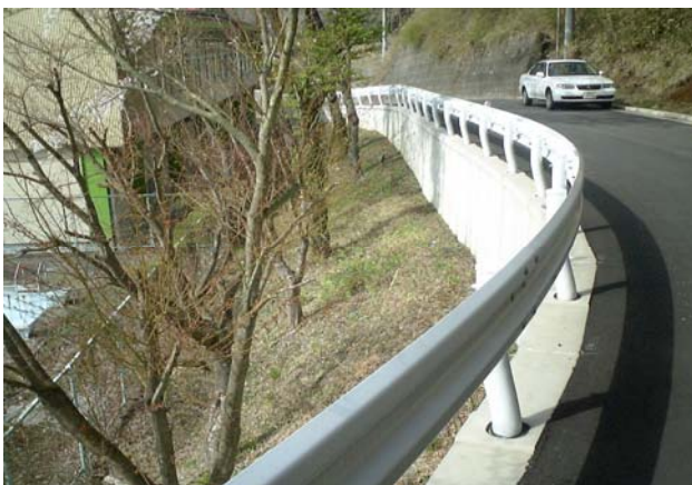
道志村池原地区道路改良工事实績写真
