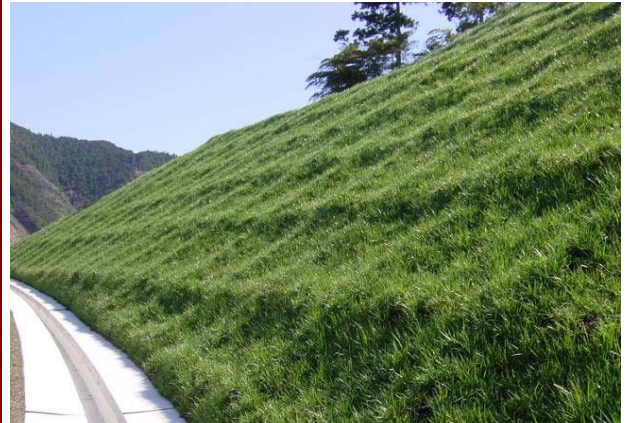
全面緑化により、景観向上
