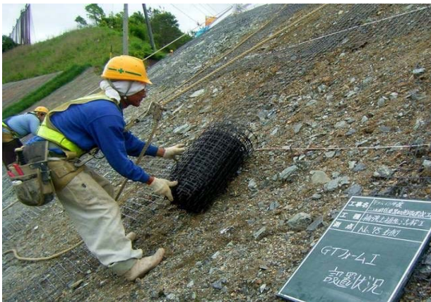
【施工状況】 ジオグリッド設置工
