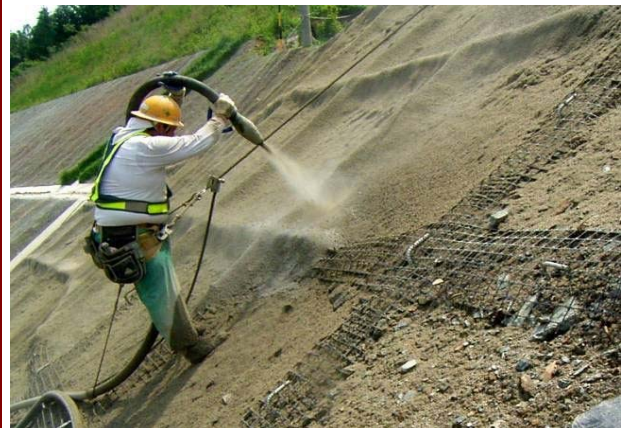
【施工状況】 改良土吹付工
