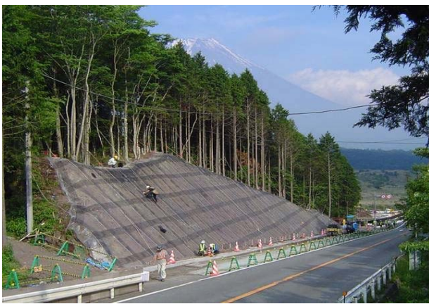
【施工事例】 施工中
