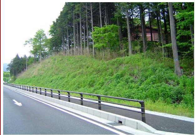
【施工事例】 施工後(2年)
